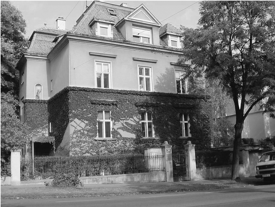
Abb. 2: Hasenauerstrasse 38: Das derzeitige Institutsgebäude in der Hasenauerstrasse 38, 1190 Wien.
